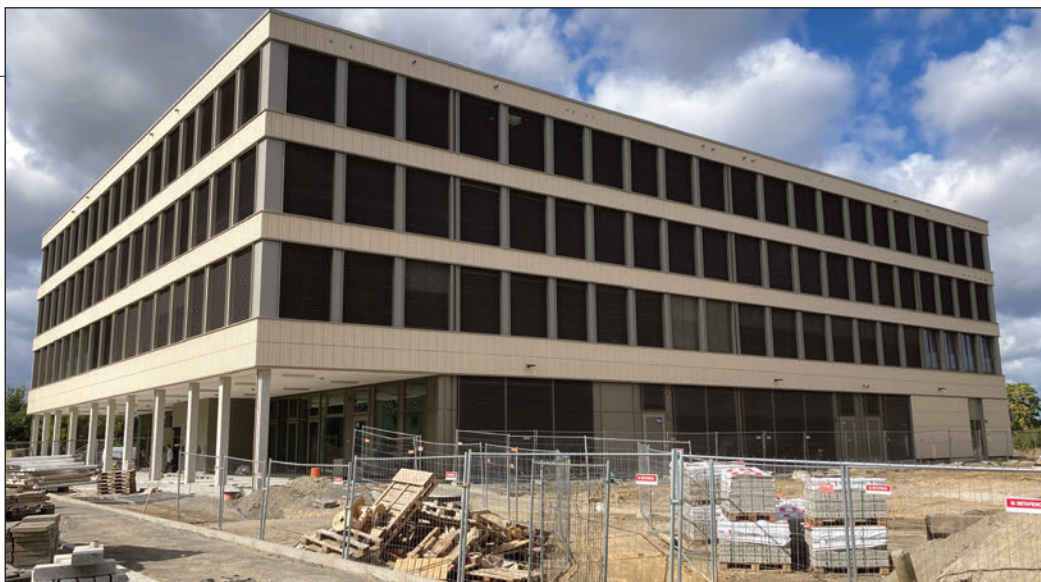
Trotz restlicher Bauarbeiten im Außenbereich läuft seit Schuljahresbeginn der Unterricht an der Grundschule.
